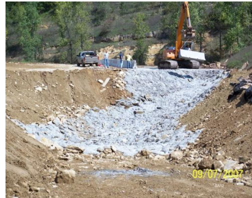
Bad Axe 12 Aux. Spwy Repair – Sept. 2007
