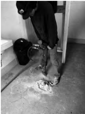
Concrete floor demo.
